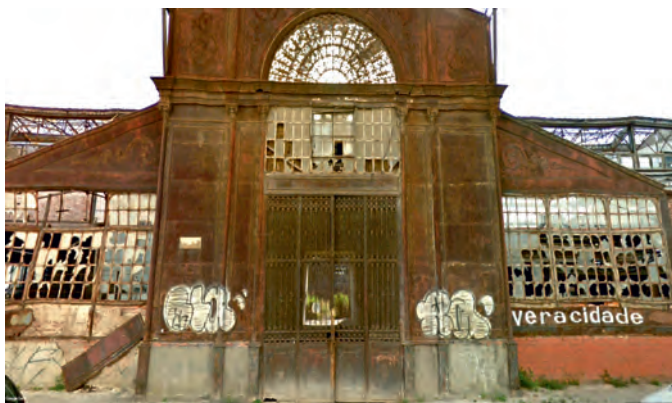
Figura 2A – Fachada do antigo edifício da Tabaqueira, em Lisboa Oriental.
